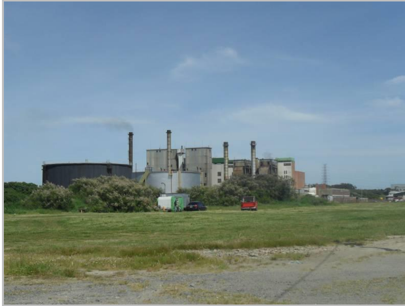
Figura 28. Vista de la central termoeléctrica.
