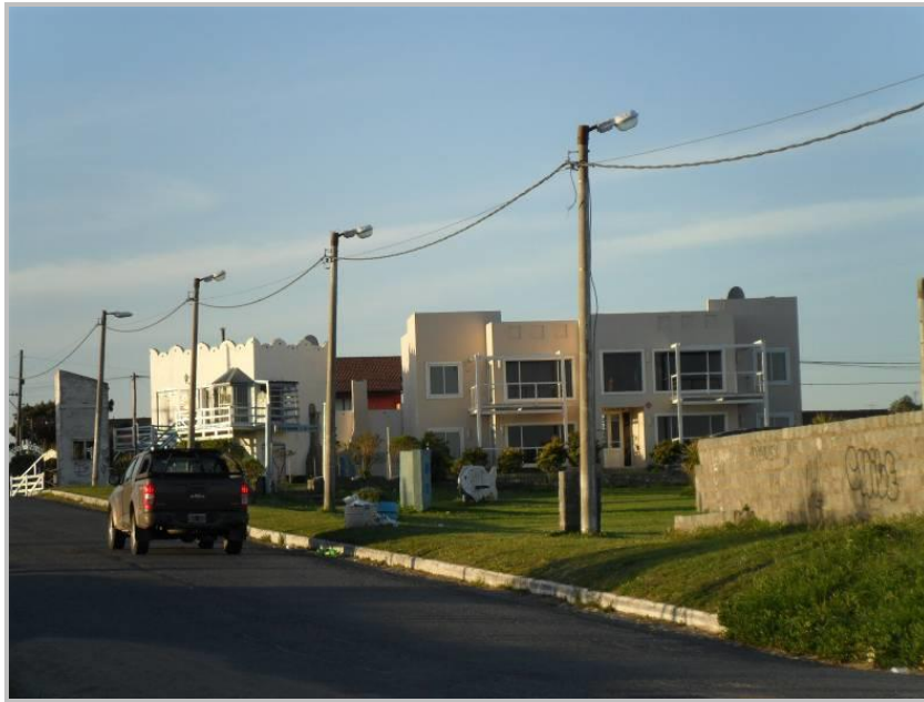
Figura 19. Vista de las edificaciones ubicadas sobre la calle 502.
