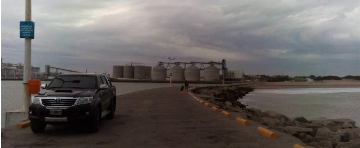
Figura 7. Escollera Norte: viaducto de acceso vehicular y peatonal.
