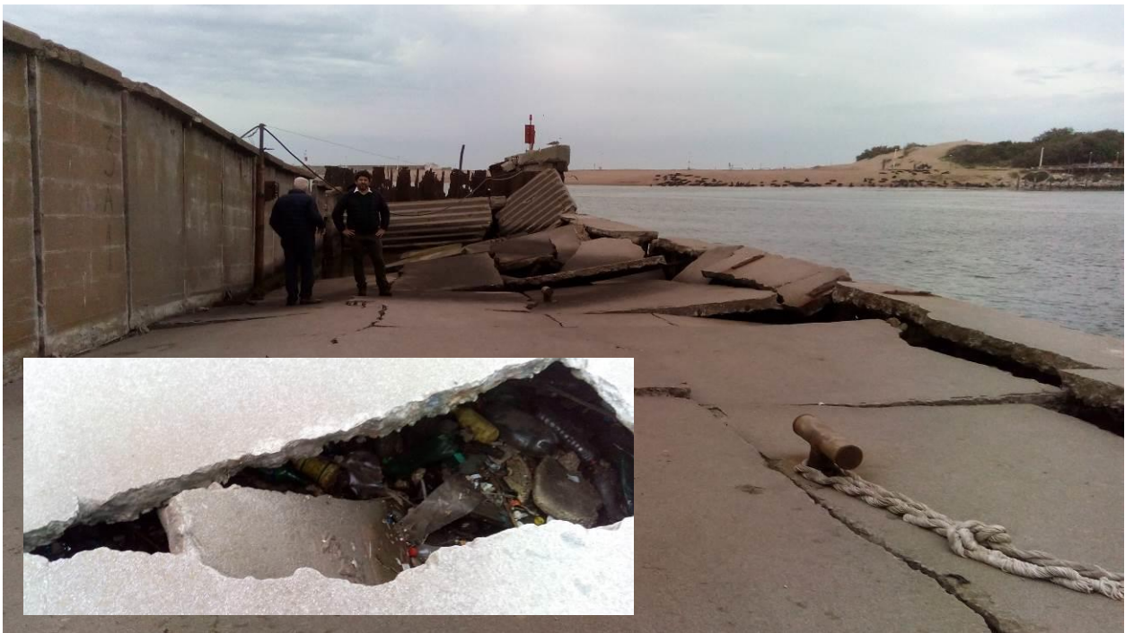
Figura 13. Espigón de Defensa: presencia de basura entre las roturas de las losas de hormigón armado.
