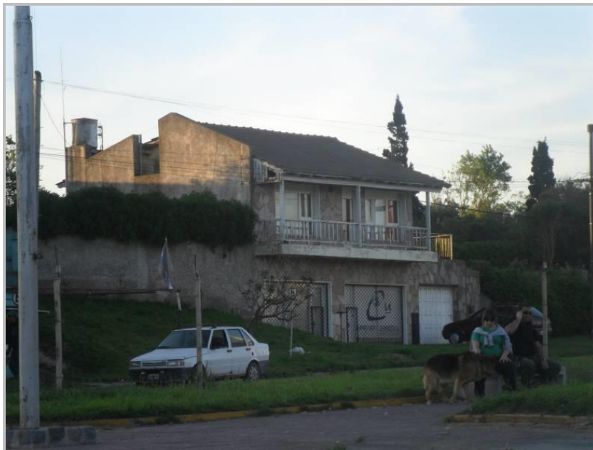
Figura 20. Vista de las edificaciones ubicadas sobre la Av. Almirante Brown.
