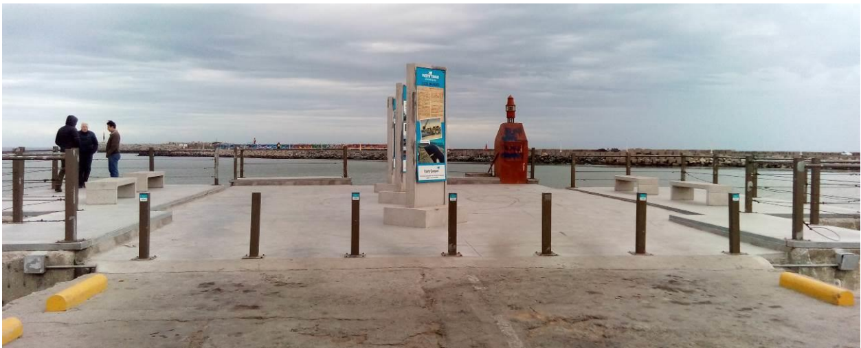
Figura 8. Extremo final de la Escollera Norte: sitio para la apreciación del paisaje y faro/baliza de señalización de la escollera.
